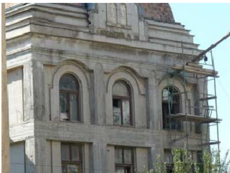
Fațada actuală a templului cu consolidarea realizată în anul 2010 36
