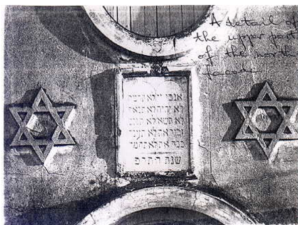
Detaliu de fațadă 33
